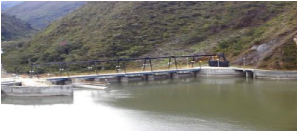
Ilustración 1 Presa de la Toma Tulumayo
