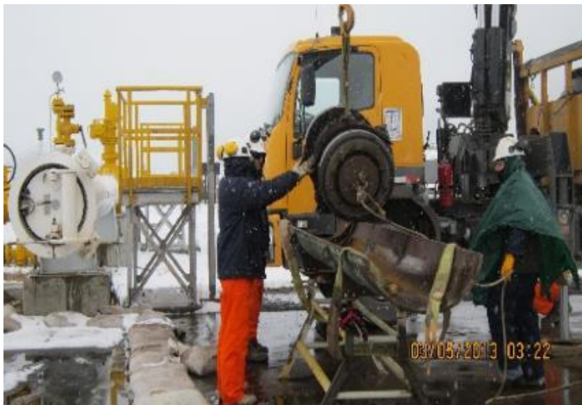
Desmontaje del PIG Y Retiro del CPU
