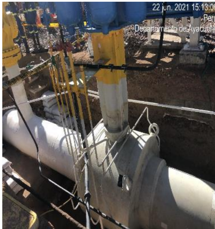
Cuerpo de la Válvula Sustraído a la Superficie
