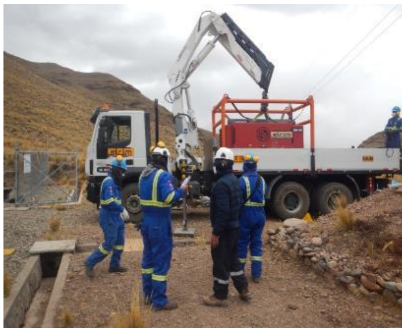
Personal Trabajando con Seguridad en el Campo
