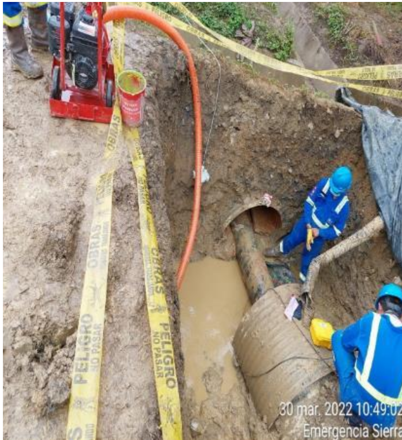
Apertura e Inspección de un Ducto de 14"
