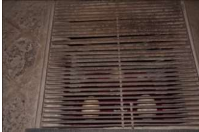
Figura 23. Rejilla de suelo en la sala de postrimerías del hombre
