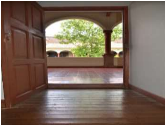
Figura 54. Vista desde dentro del ingreso a segunda celda con representaciones de recamaras de franciscanos (segundo nivel)
