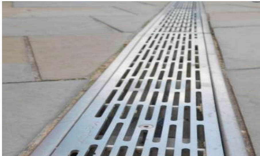
Figura 75. Ejemplo de rejillas accesibles
