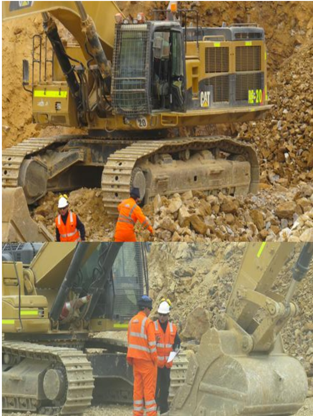
Figura 29. Equipos CAT Modelo 385 – 390- mina Tantahuatay Fuente: Compañía Coimolache S.A.-2015.
