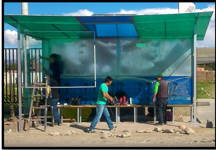
FIGURA: 3.4-“Implementacion del Techo y de la Banca del Paradero”
