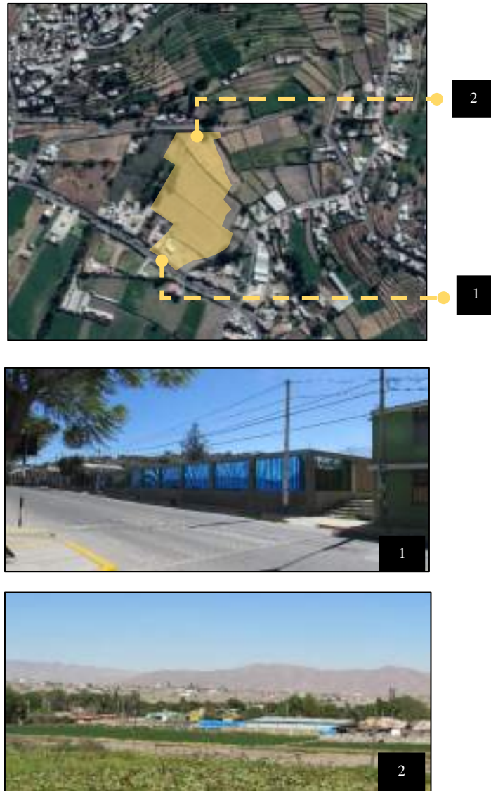
Figura 48. Imágenes de situación actual del terreno
