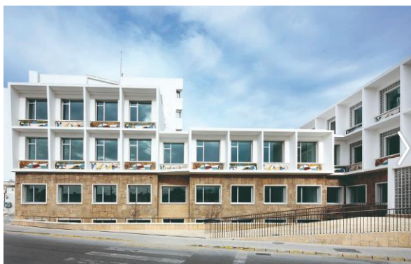
Gráfico 14: Figura representativa del edificio: Rehabilitación Antiguo Ambulatorio.
