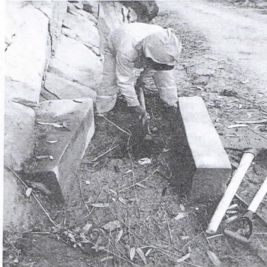
LIMPIEZA DE ALCANTARILLA PROGRESIVA 2+830
