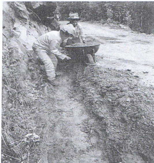
LIMPIEZA CUNETAS PROGRESIVA 7+250
