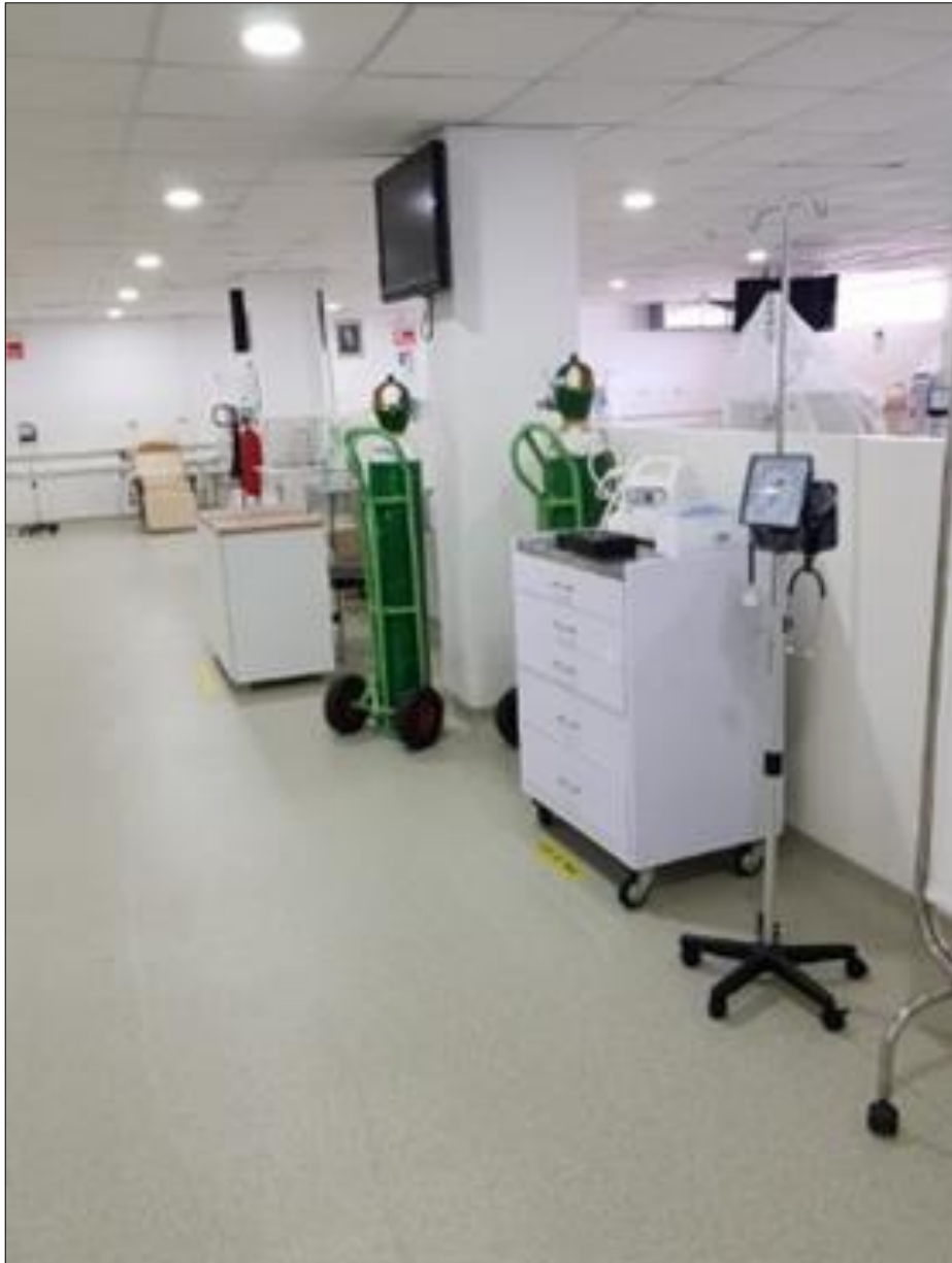
Foto de la Sala de Tratamiento de Hemodiálisis – oxígeno y tensiómetro
