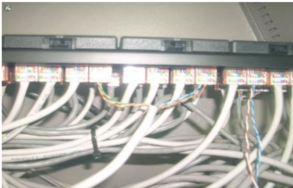
Gráfico 5: Error de conexión con Jack Modulares al patch panel
