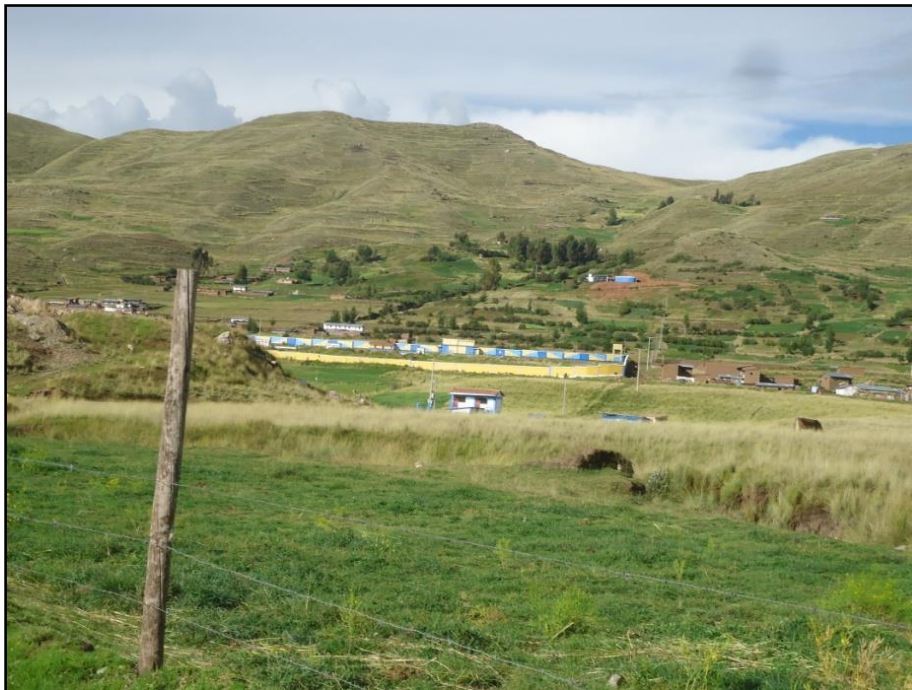
Impulsión de agua para consumo de agua.
