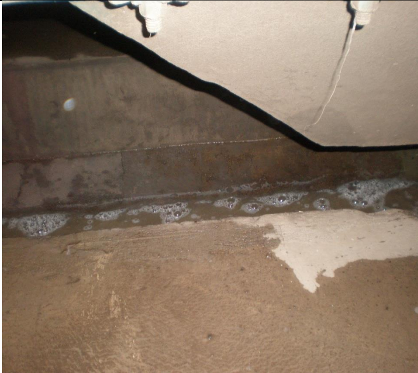
Canal actual de salida del efluente
