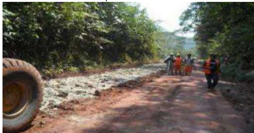
Figura III.5. Esparcido de cemento
