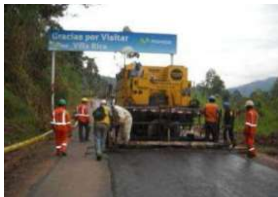
Figura II.3. Colocación de slurry seal
