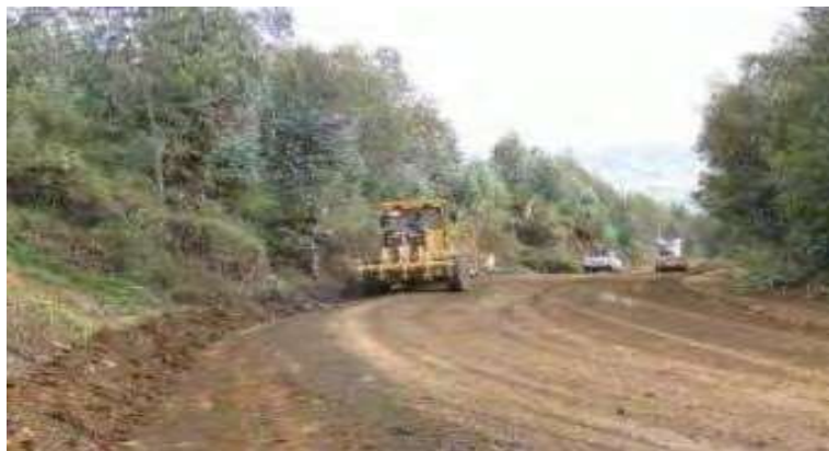
Figura III.4. Preparación de la Sub Rasante
