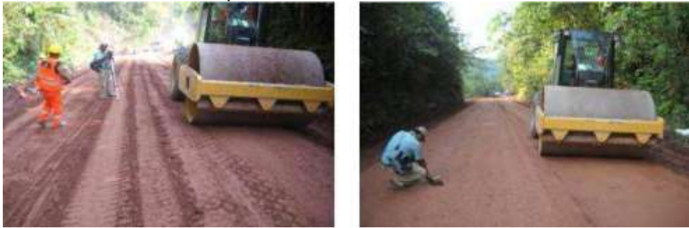
a) Inicio de compactación con rodillo liso b) Acabado final con rodillo liso
