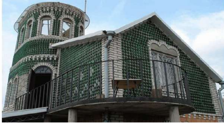
Figura 2.22 Arquitectura popular construcción con PET
