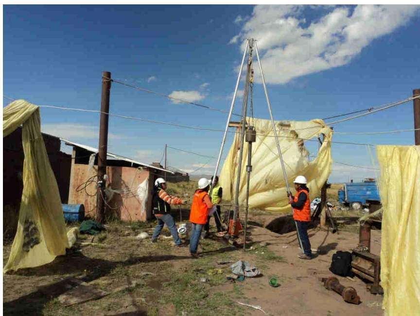
Imagen 1 Ensayo de Penetración Estándar (SPT)
