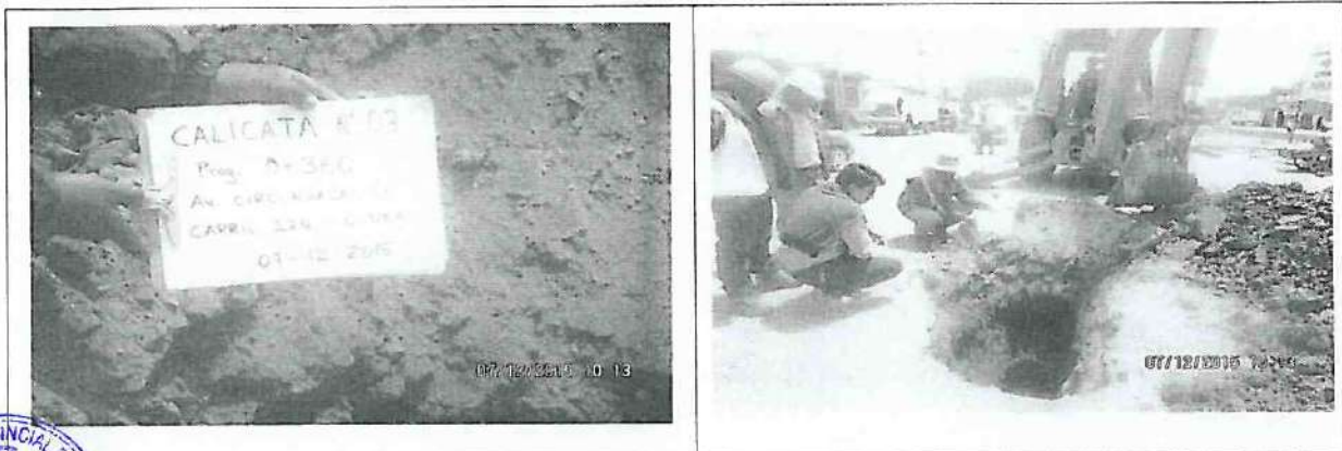
FOTOS CALICATA C-03
