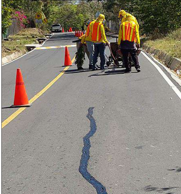
Figura 46. Sellado de grietas
