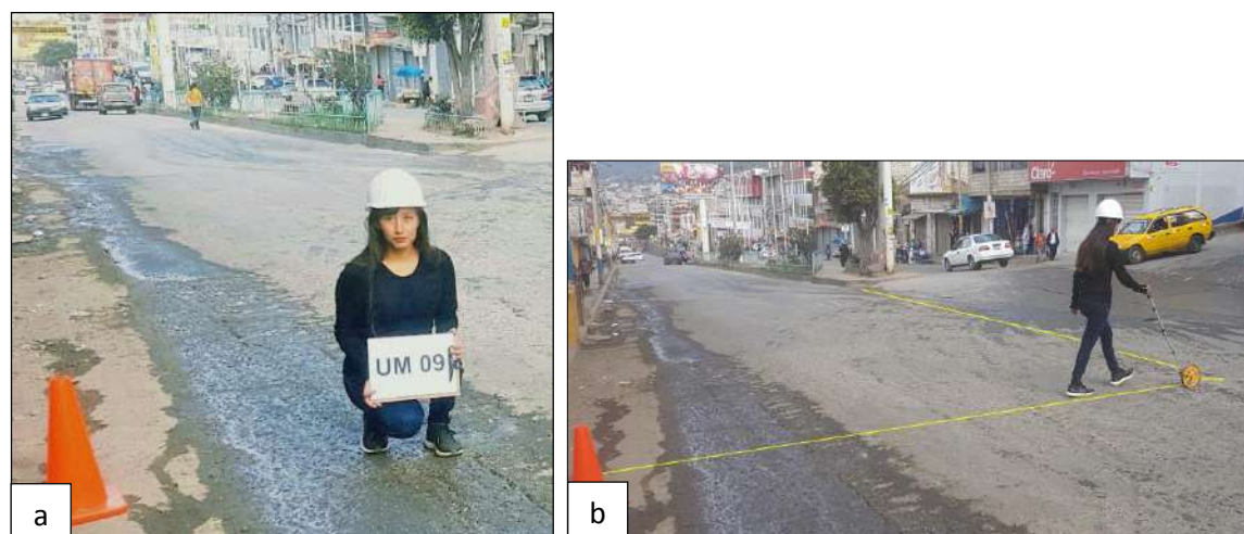
Figura 115. Señalización (a) y delimitación (b) de la UM 09, inicio de la sección 2
