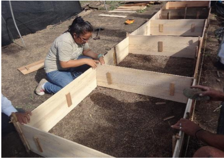
Foto 2: Construcción de los cajones.
