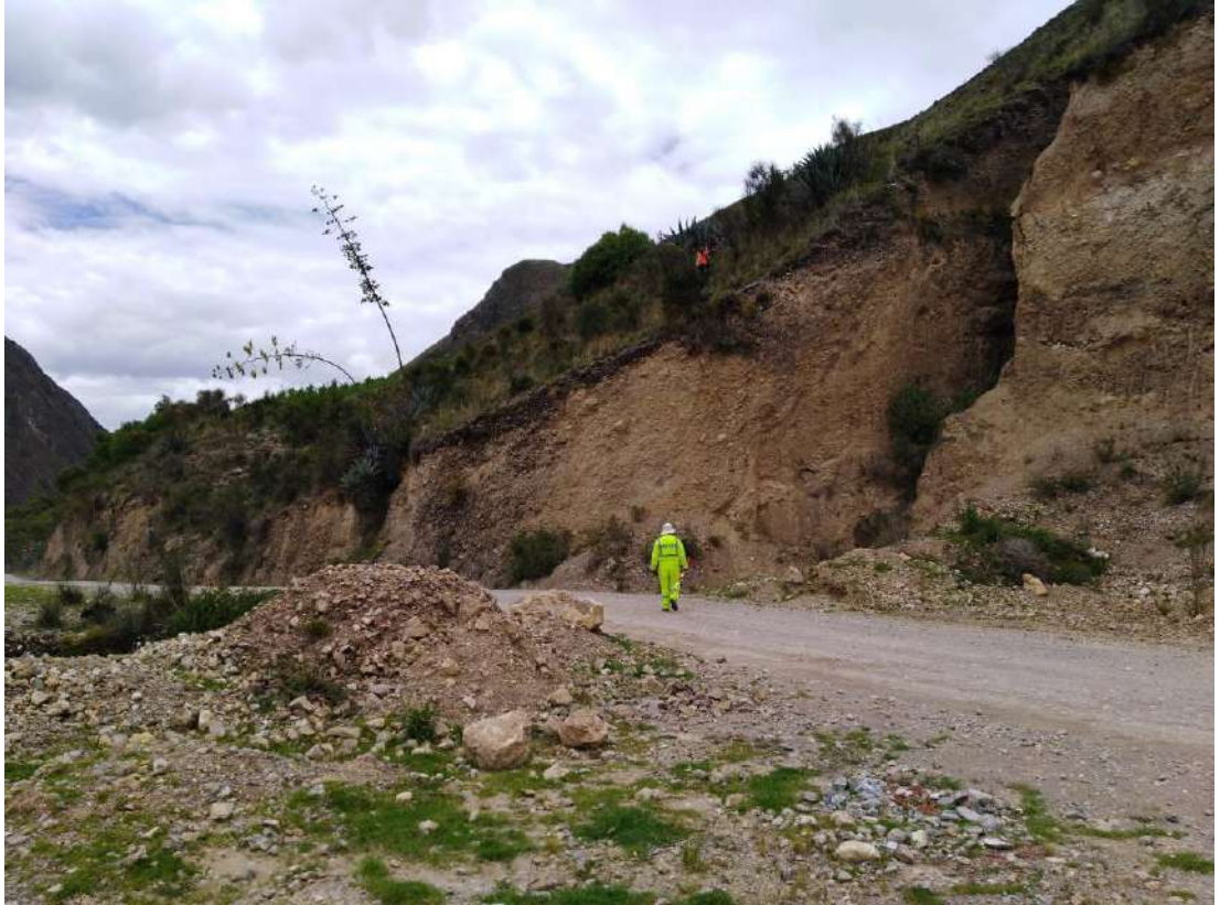
Vista de toma de datos en los taludes
