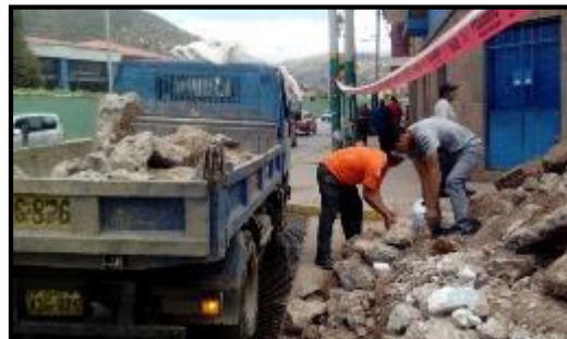
Carguío y transporte del concreto reciclado.
