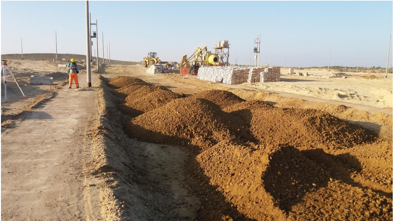
IMAGEN N° 15: Colocacion de afirmado para capa base
