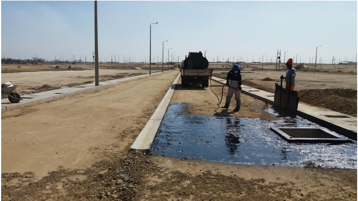
IMAGEN N° 16: Imprimación de base para colocación de carpeta asfáltica
