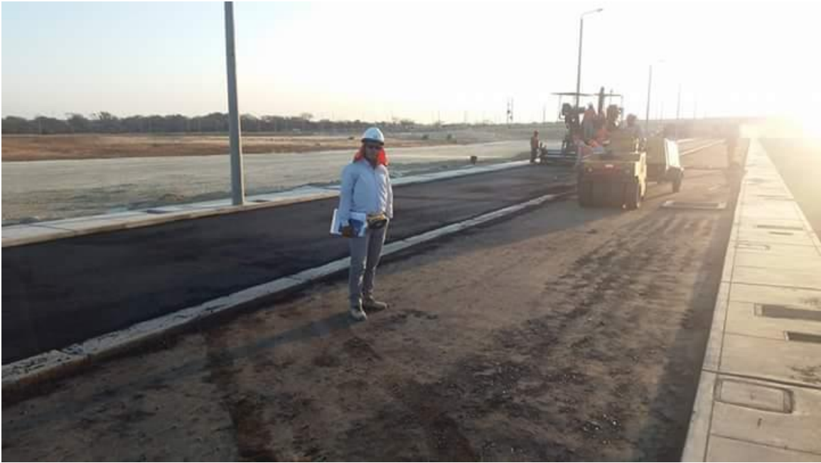
IMAGEN N° 17: Colocación de carpeta asfáltica – calle 11
