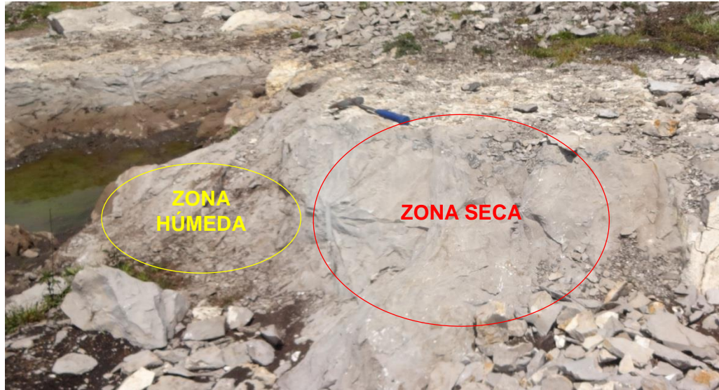
Figura 27 Presencia de agua en las discontinuidades
