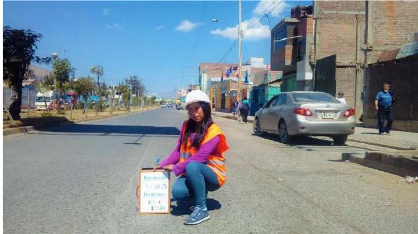
Figura 7. 7: Grieta Longitudinal 00 + 108.25 m
