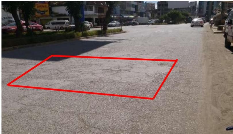
Figura 3. 16: Agrietamiento en bloque. (BLO, unidad de medida: m2)
