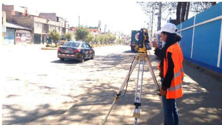
*Figura 3. 2: Levantamiento topográfico de la Avenida Jacinto Ibarra - Huancayo*
