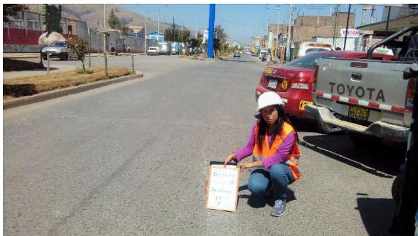
Figura 7. 4: Grieta Longitudinal 00 + 047.83 m
