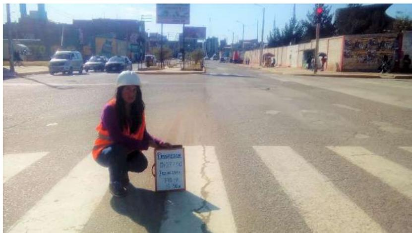
*Figura 7. 29: Grieta Longitudinal 00 + 297.50 m*
