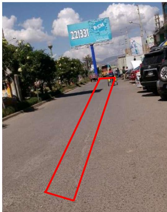
Figura 3. 14: Grietas Longitudinales. (GL, unidad de medida: m)
