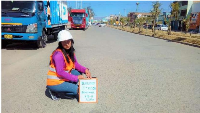
Figura 7. 16: Grieta Longitudinal 00 + 143.00 m
