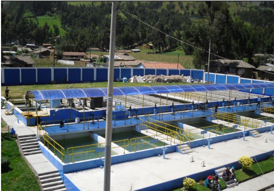
Foto N° 02: P.T.A.P en Vilcacoto - SEDAM Huancayo S.A. (planta nueva)
