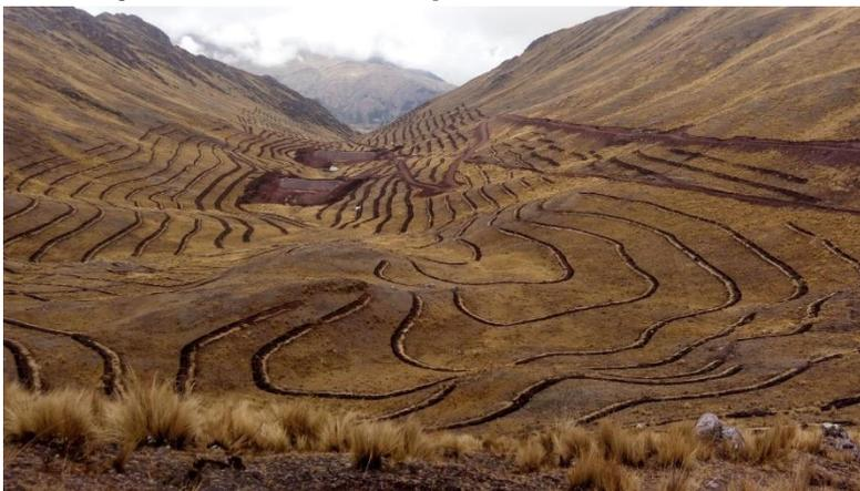
**Foto 3: Otra vista de las zanjas de infiltración**
