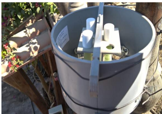
Figura N°21: Instalación de tubos difusores listos (1er Punto-Hotel EL Carmelo)
