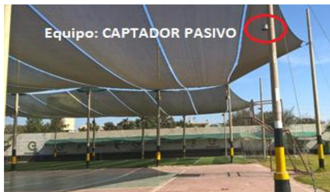
Figura N°15: Tubos de difusión complejo deportivo UAP
