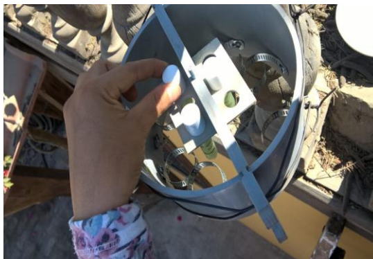
Figura N°20: Instalación de los contenedores y tubos difusores (1er Punto-Hotel EL Carmelo)
