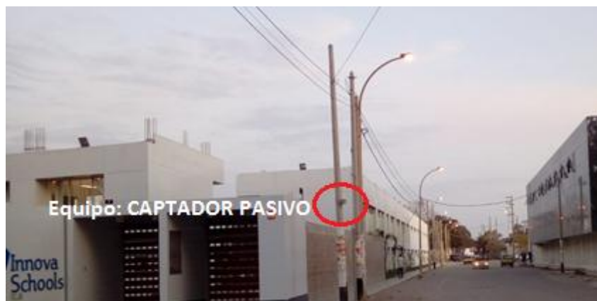
Figura N°25: Instalación de tubos difusores (3er Punto-Innova Schools)
