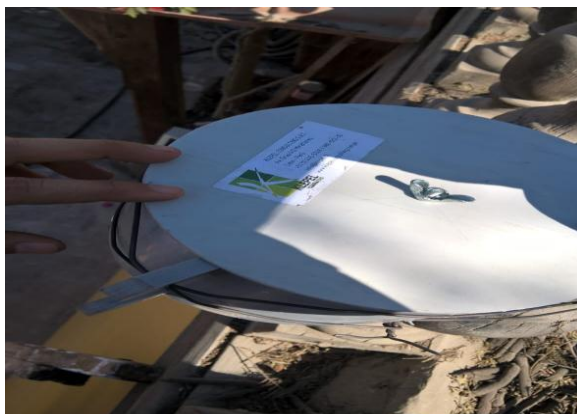
Figura N°22: Instalación de tubos difusores listos en el punto de monitoreo (1er Punto-Hotel EL Carmelo)
