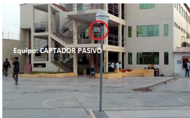
Figura N°17: Tubos de difusión Patio central de la UAP
