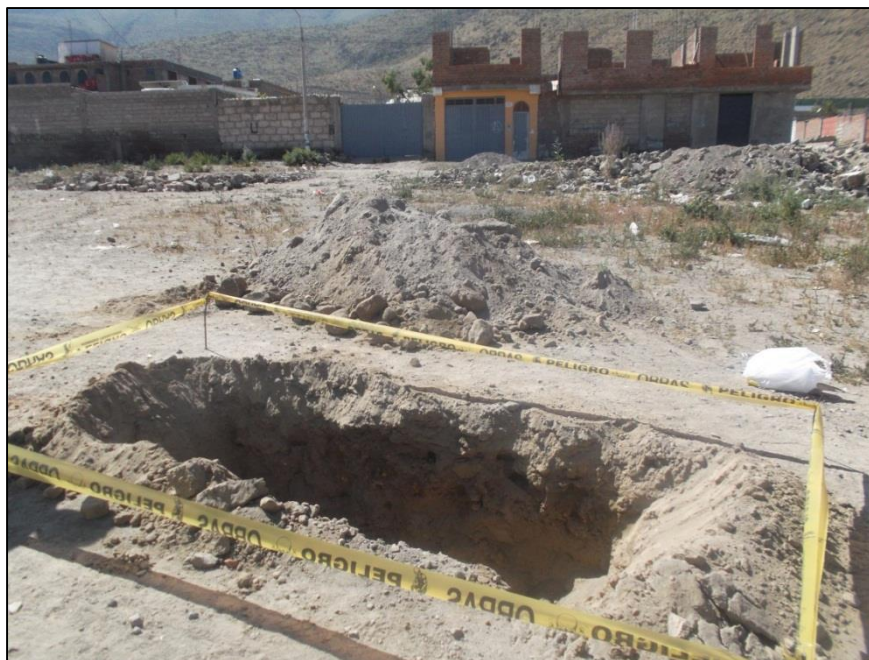
Figura 4-9: Foto Panorámica de la Calicata C-04
