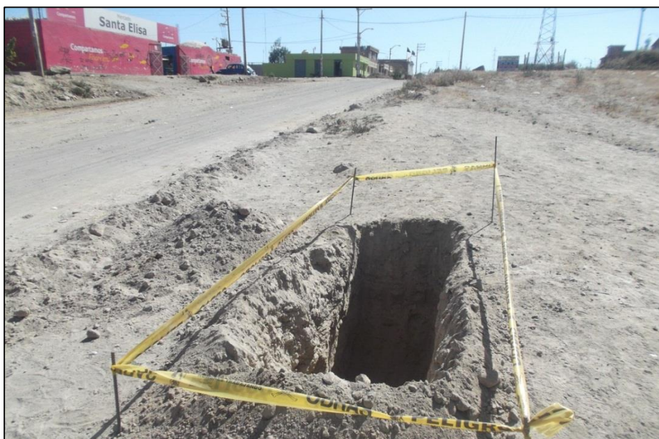
Figura 4-6: Foto Panorámica de la Calicata C-02
