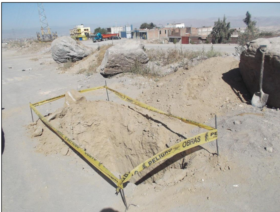
Figura 4-4: Foto Panorámica de la Calicata C-01
