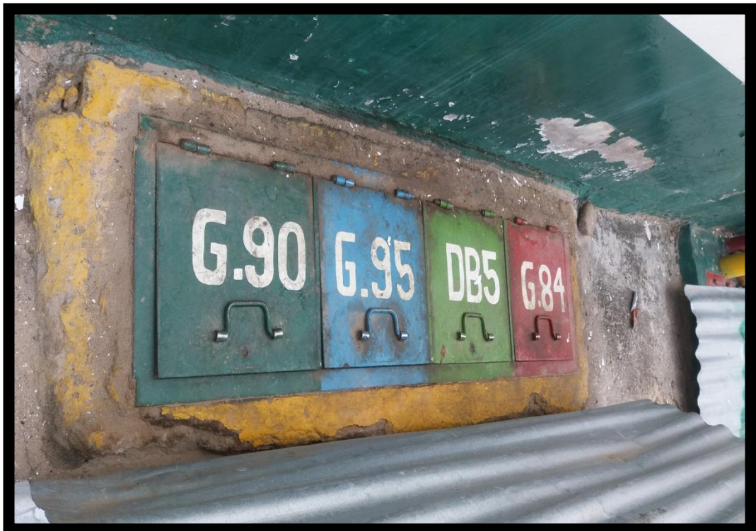
Foto 5: Inspección al recuperador de vapor.
