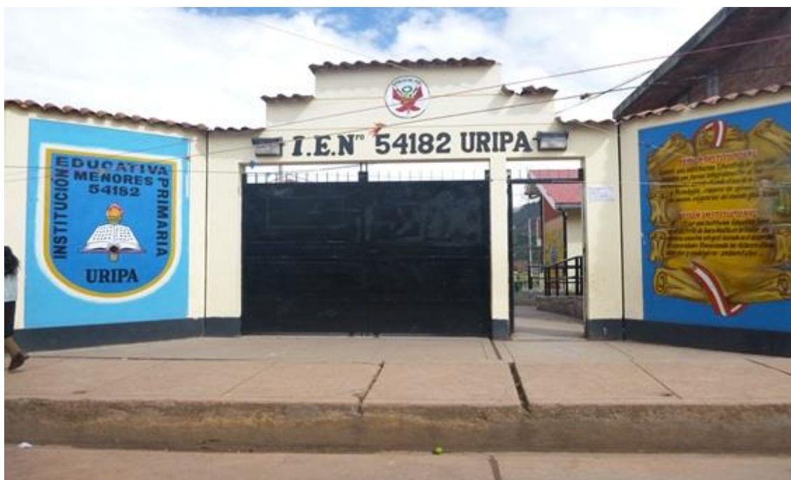
Figura N° 1. Entrada principal de la Institución Educativa N° 54182 "Uripa", distrito de Anco - Huallo, provincia de Chincheros, departamento de Apurímac; donde se realizó la investigación.
