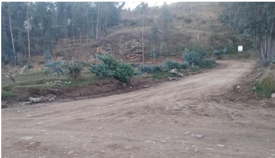
Figura 1: carretera circuito cruz de paz palian Huancayo
