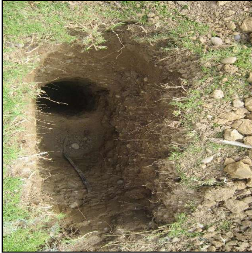
Fotografía N° 03 – vista de la calicata n°1
