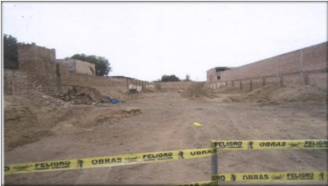
Figura N°26: Vista Panorámica de la zona de Estudio.
