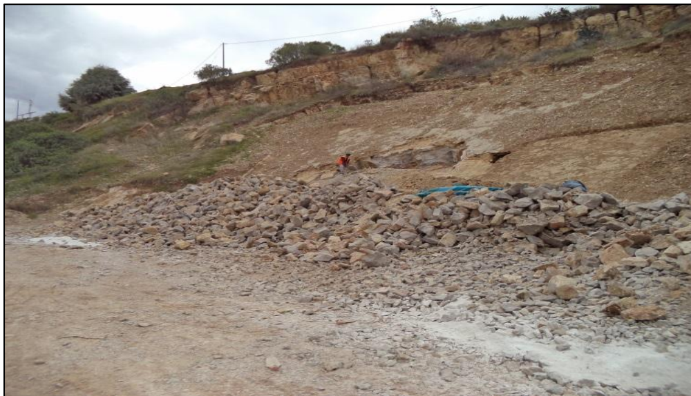
Figura26: Roca caliza chancada en cantera. (Chancado primario) - 2016. Fuente: Elaboración propia - 2016.
