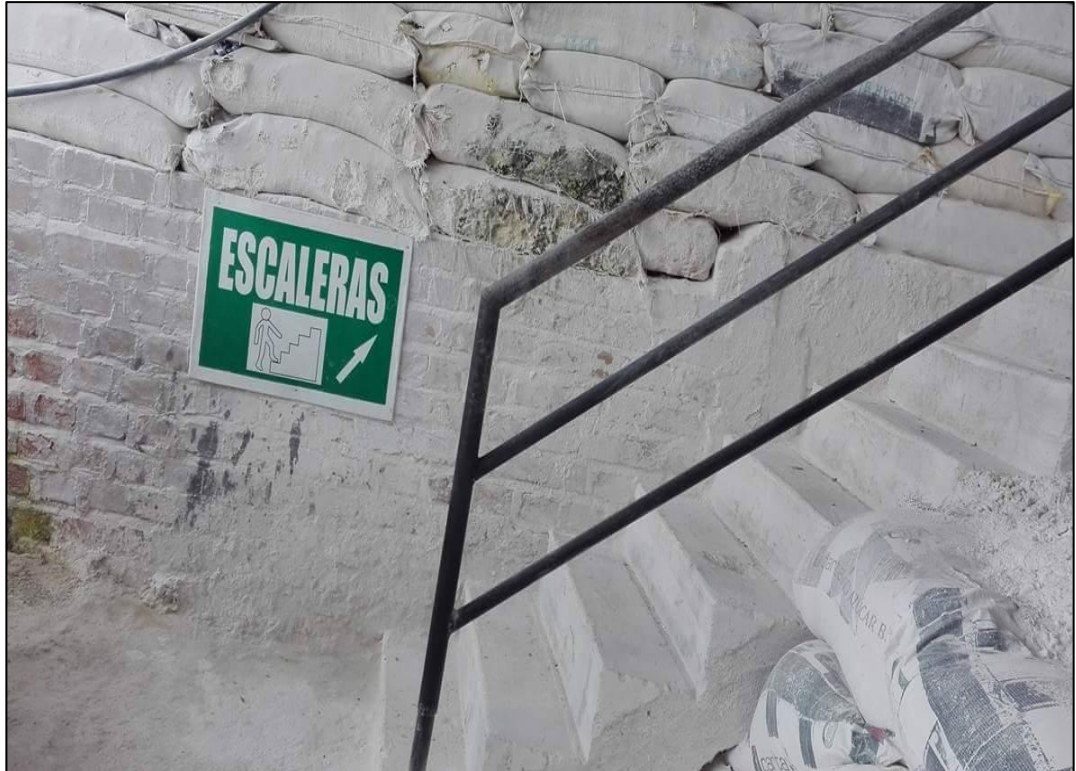
Figura 52: Señalización de escaleras a los hornos de producción del proyecto – 2016. Fuente: Elaboración propia – 2016.
