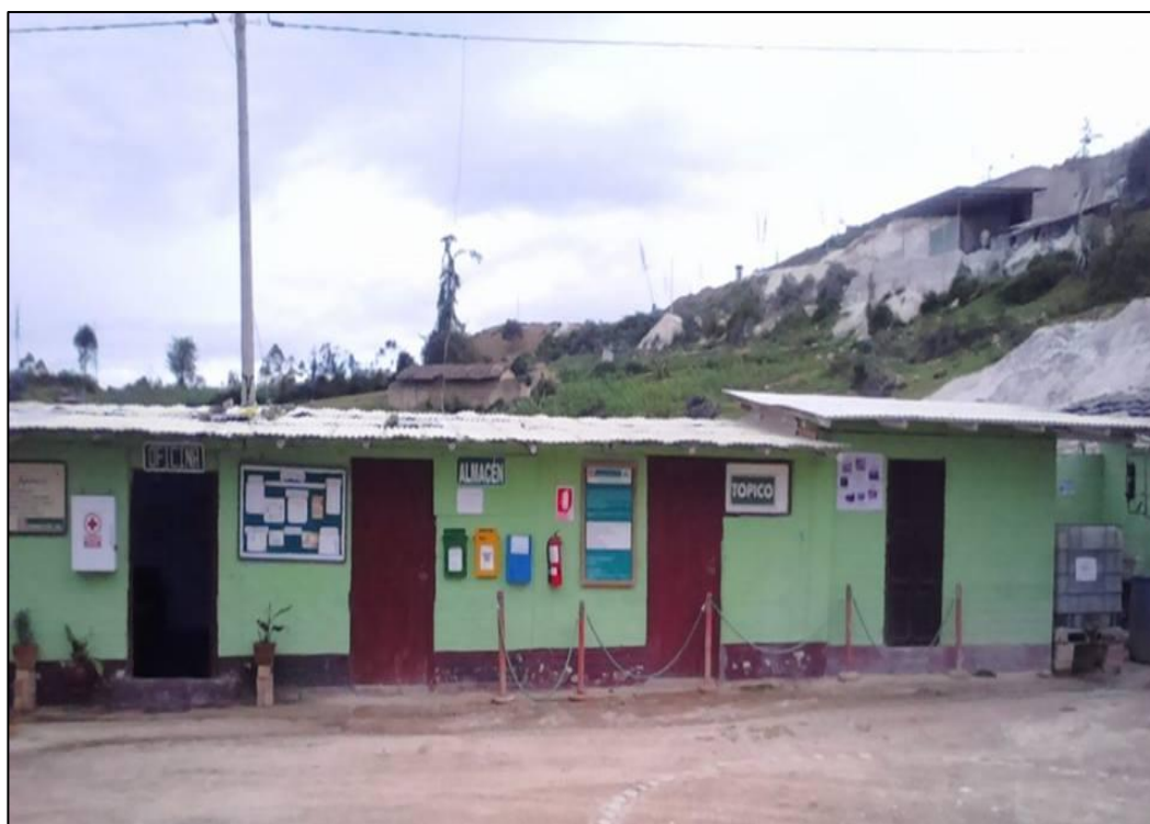
Figura 47: Instalaciones de oficinas centrales del proyecto – 2016.
