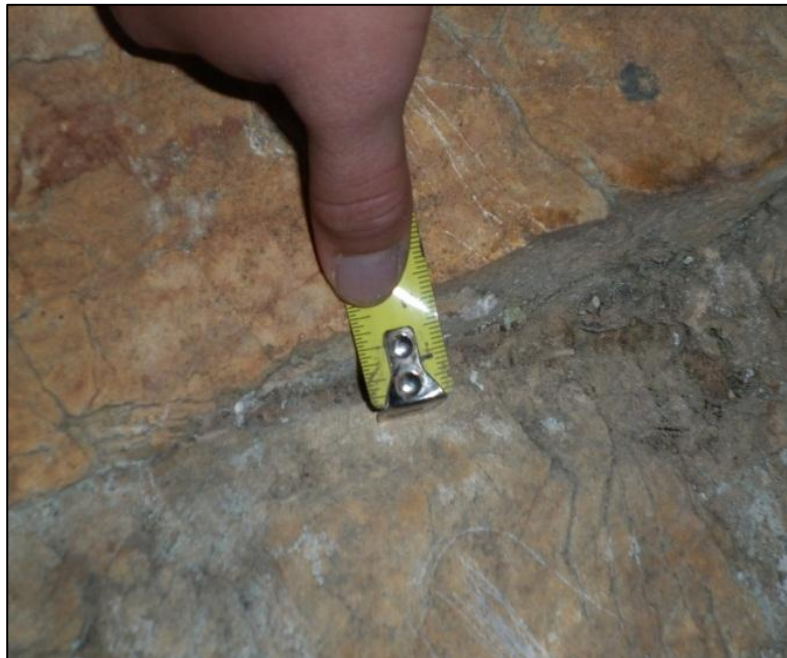
Figura 12: Abertura del macizo rocoso – 2016. Fuente: Elaboración propia – 2016.
