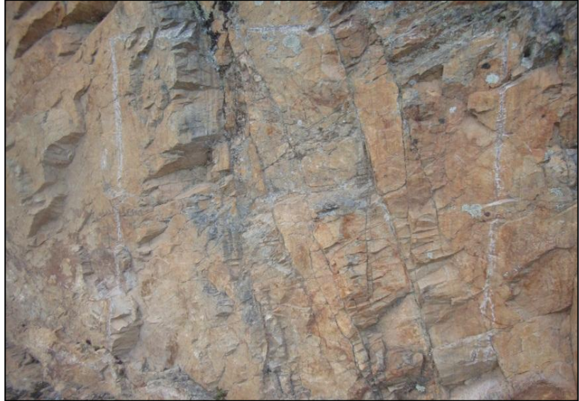
Figura 5: Dominio estructural del macizo rocoso – 2016. Fuente: Elaboración propia – 2016.
