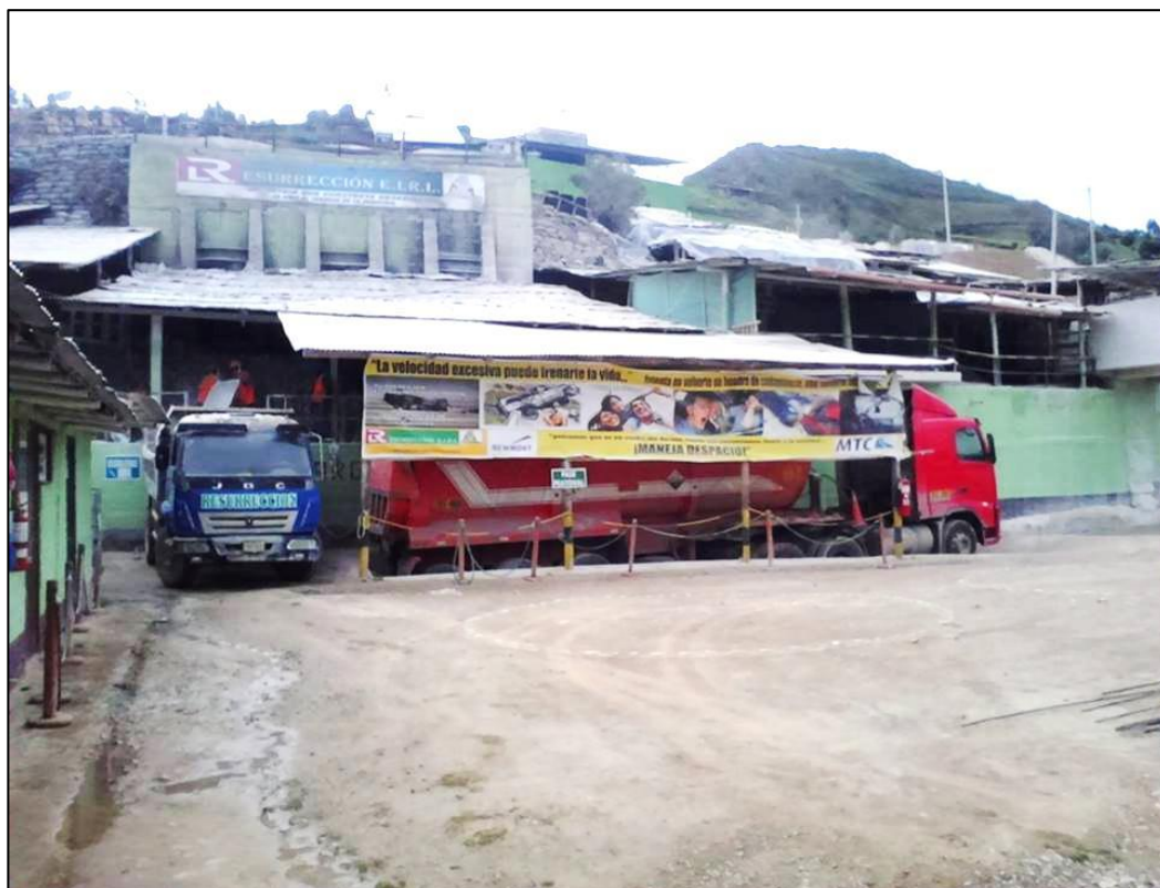
Figura 46: Instalación de zonas de carguío del proyecto – 2016.
