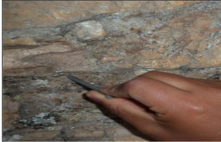
Figura 13: Relleno del macizo rocoso – 2016. Fuente: Elaboración propia – 2016.
