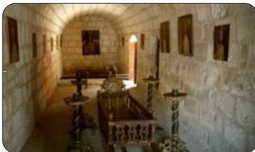
Figura 2.3 Construcción tipo bóveda dentro del Convento de Santa Catalina
