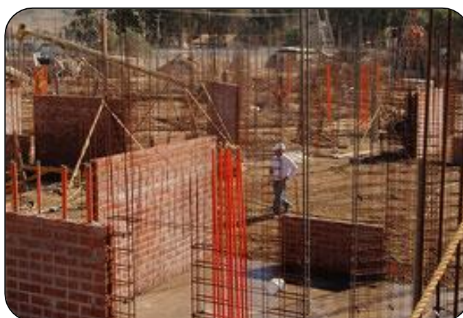
Figura 3.1 Sistema de albañilería armada
