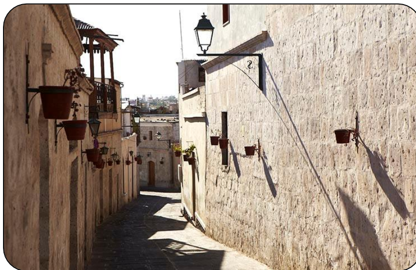
Figura 2.11 Vista de utilización de unidades de albañilería de sillar en muros: Barrio de San Lázaro
