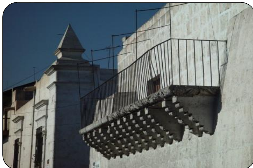
Figura 2.5 Ménsulas de sillar en los balcones de las casonas coloniales
