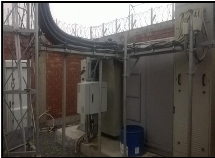
Figura 19. Interior de la estación de Claro 2016
