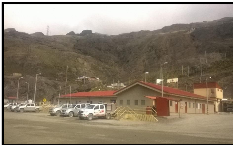
Figura 10. Oficinas administrativas de la unidad minera San Rafael Minsur
