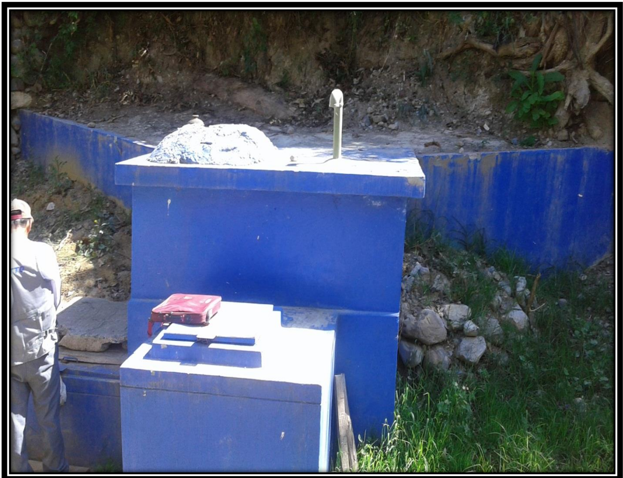
Figura 9.- Cámara de captación de agua.
