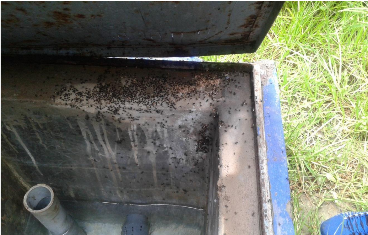
Figura 27.- Presencia de insectos en la la captación y agua del manante Mariño.
