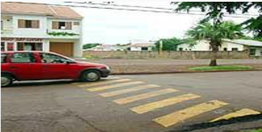
Imagen 3. Resalto con banda ancha y extensa.
