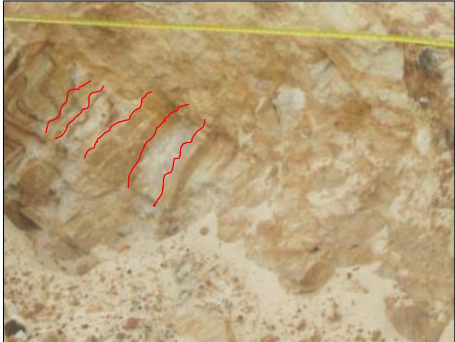
Figura 11: Fracturas planares. Fuente: Elaboración propia, (2018).
