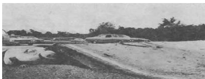
Figura 4: Rotura por pandeo de gravedad alta.
