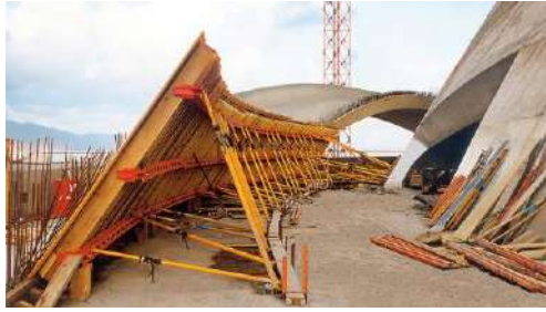
Fig. 18. Posicionamiento del encofrado interno VARIO GT 24 para las paredes curvadas e inclinadas en forma de vela. El anclaje de los soportes en la losa intermedia
