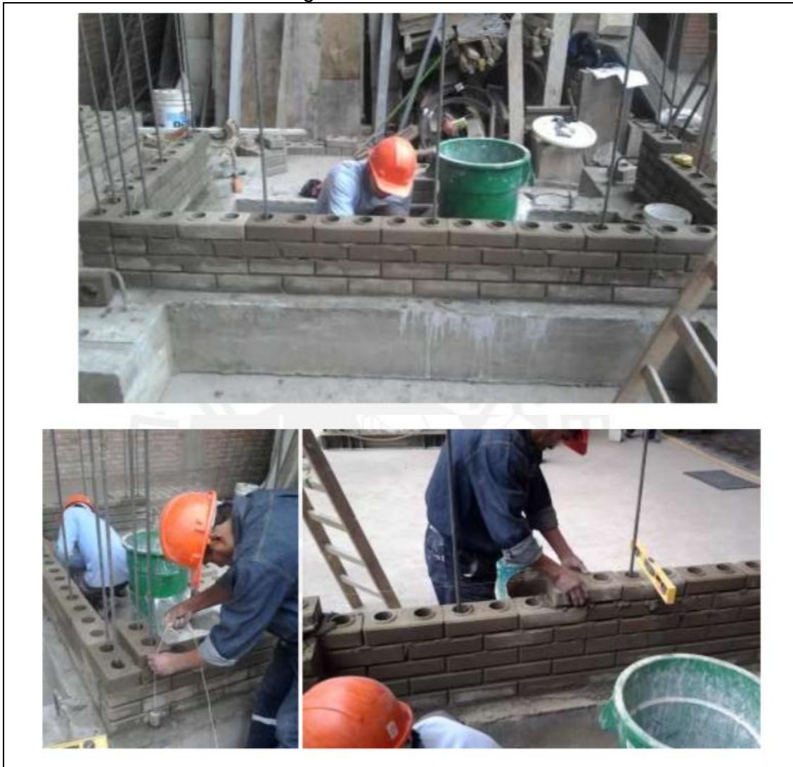
FIGURA NRO. 12 Asentado de ladrillos Ecologicos Prensados con sus Refueros Verticales
