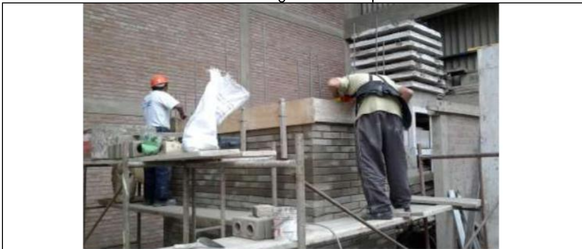
FIGURA NRO. 14 Armado de la viga solera del primer nivel
