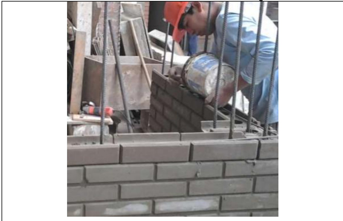
FIGURA NRO. 08 Colocación del Refuerzo Vertical en los Ladrillos Ecológicos Prensado
