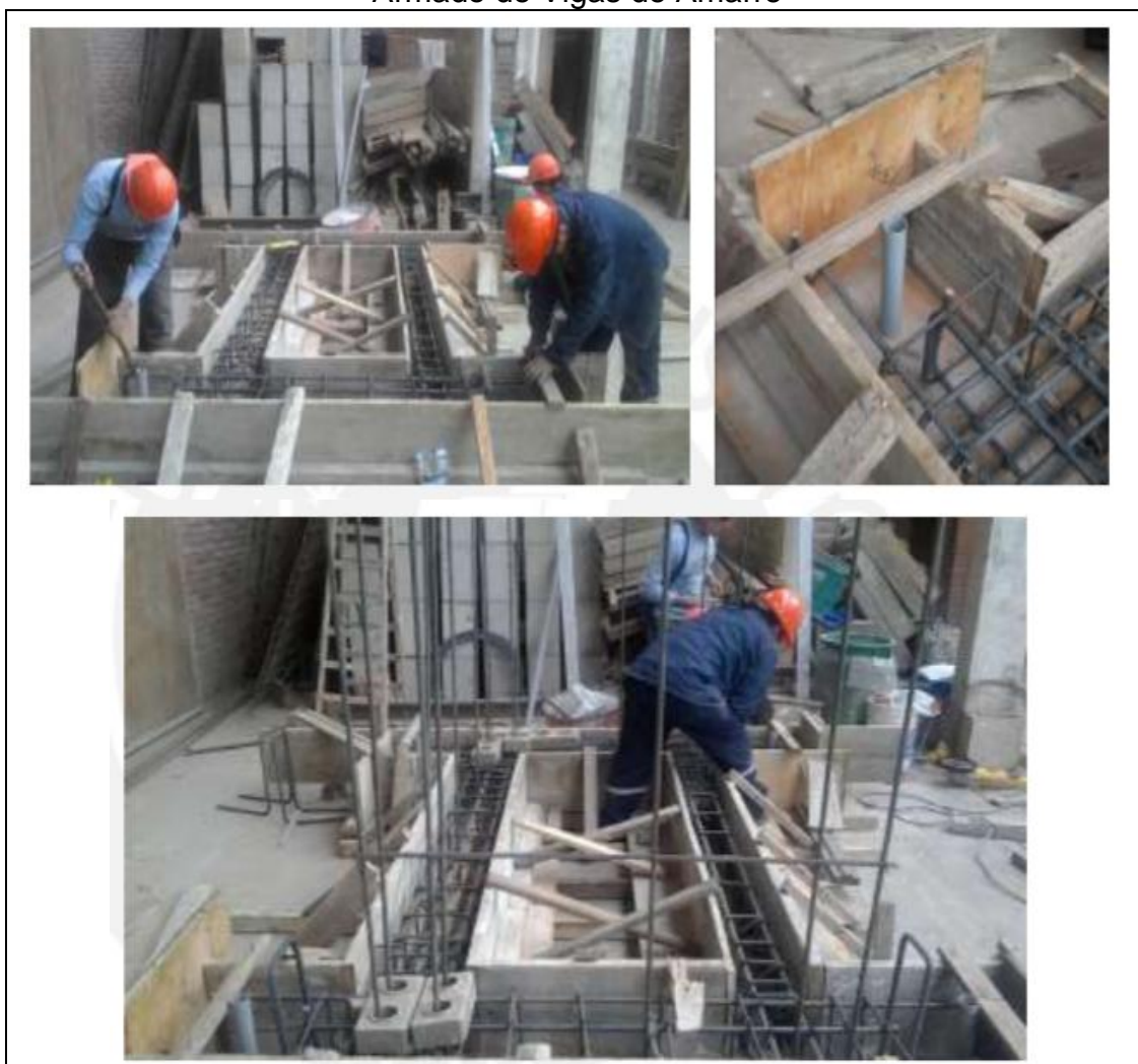
FIGURA NRO. 10 Armado de Vigas de Amarre
