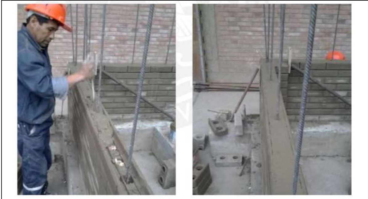
FIGURA NRO. 13 Armado de la hilera para el refuerzo horizontal con los ladrillos de viga
