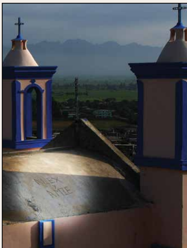
Nombres cincelados en el cemento que cubre la cúpula de cañón corrido de la ermita de la virgen. Febrero 2008
