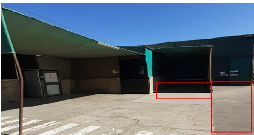
Zona de recepción
