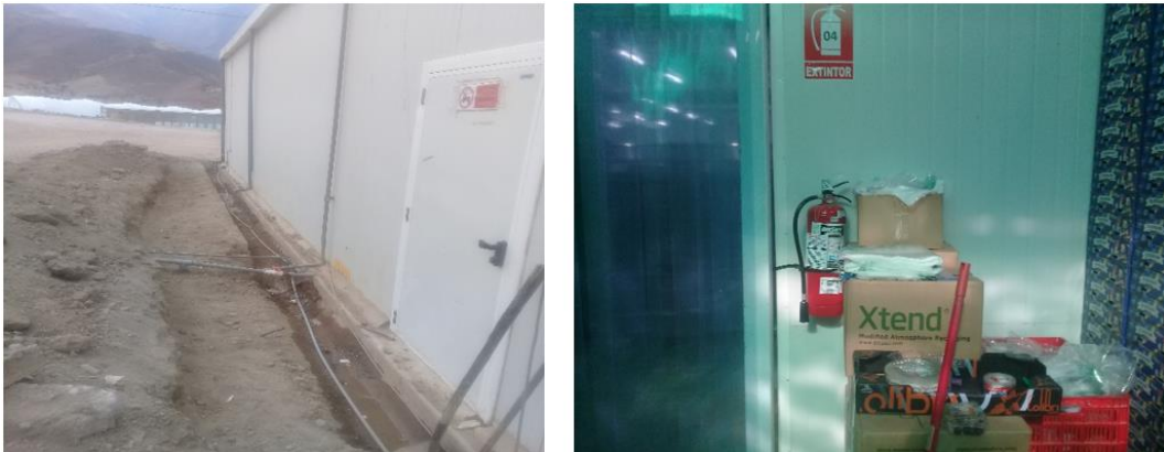
Imagen 9 Equipos de Emergencia Obstruidos
