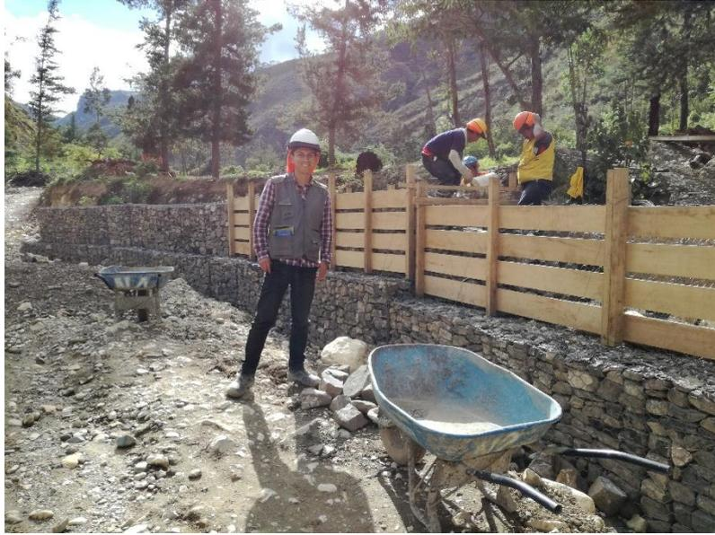
Figura 16. Encofrado del muro de gaviones.
