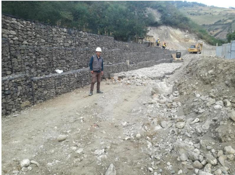
Figura 17. Armado y colocación del colchón reno.
