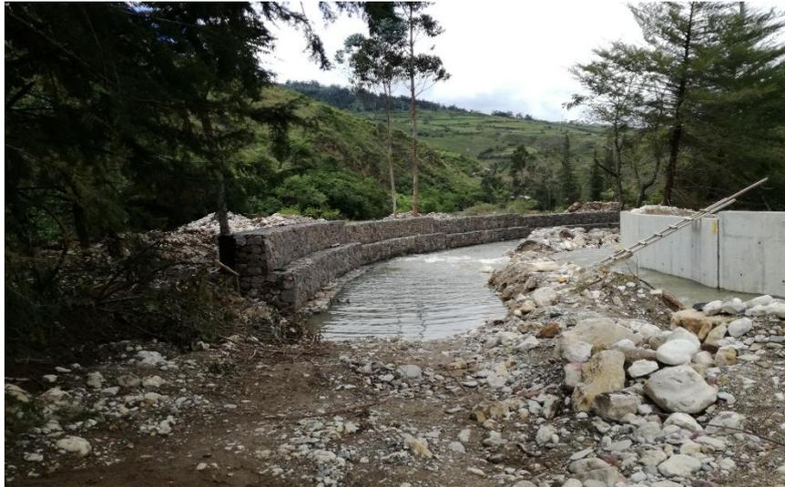
Figura 5. Muro de gaviones.
