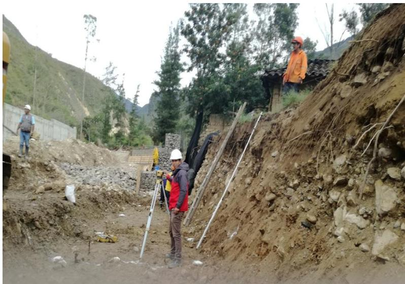
Figura 13. Nivelación para el muro de gaviones.
