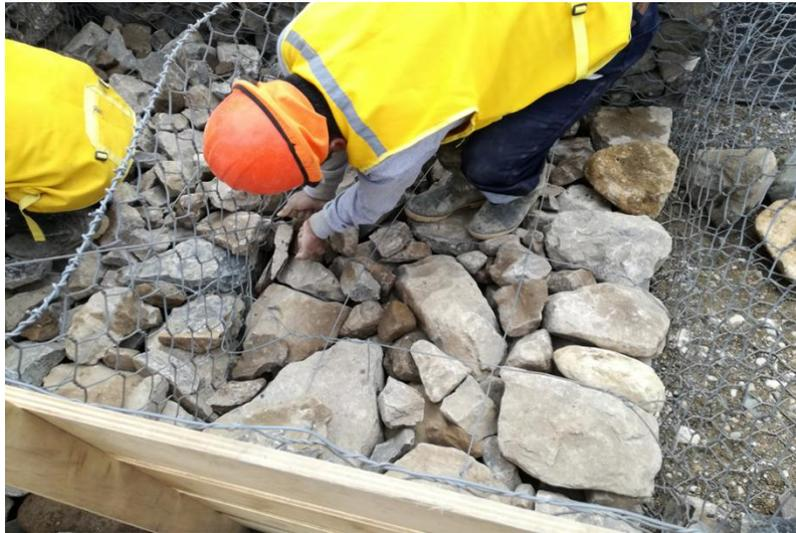
Figura 14. Atirantado de caja del gavión.
