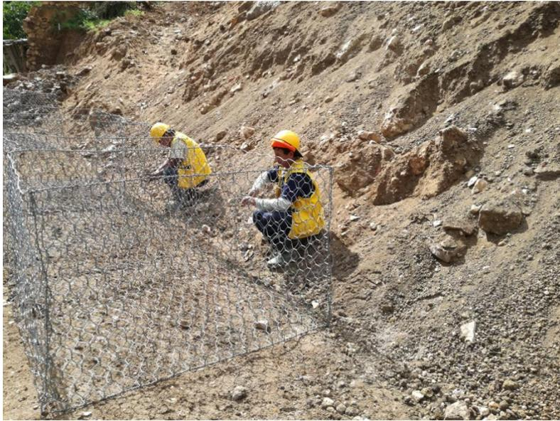
Figura 12. Armado de caja de gaviones.
