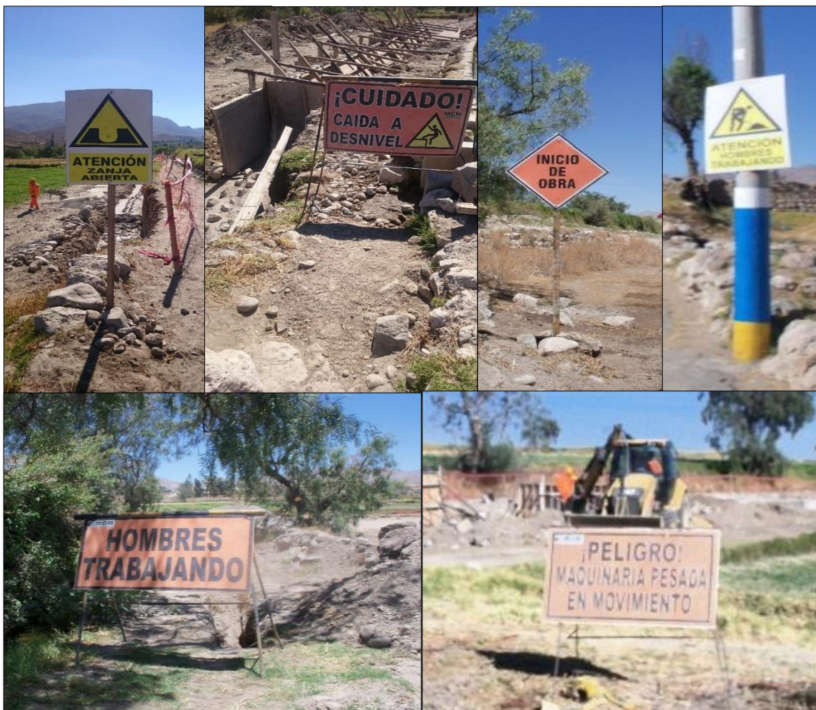
Figura n° 10: Señalización en obra
