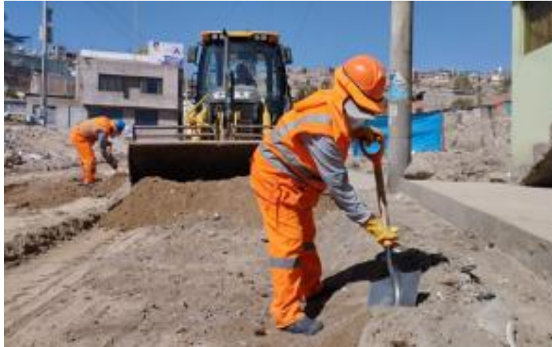
Escarificación de Terreno Para el Adoquinado
