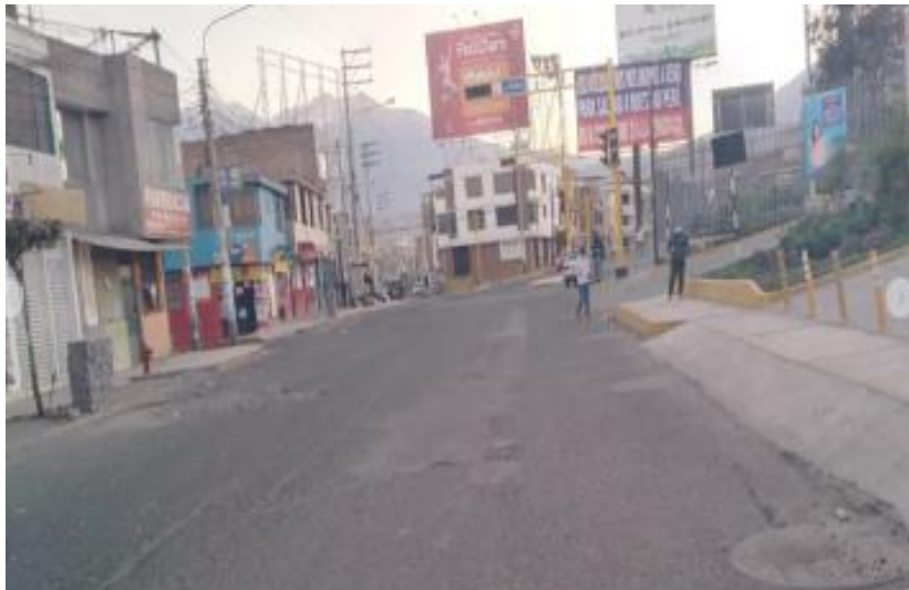
Estado Actual de la Avenida Porongoche
