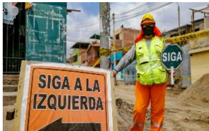
Señalización de Desvíos en la Obra
