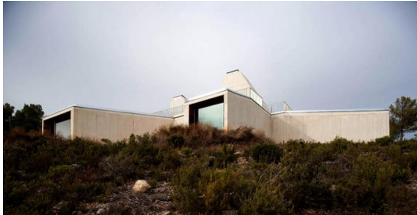
Ilustración I-02: Vista exterior del conjunto del Centro de Interpretación del Parque Natural Los Calares del Mundo y de la Sima
