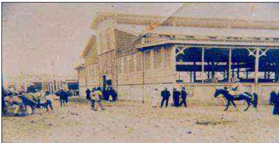
IMAGEN N ° 10: Antiguo Mercado de Abastos de Huacho - 1919.
