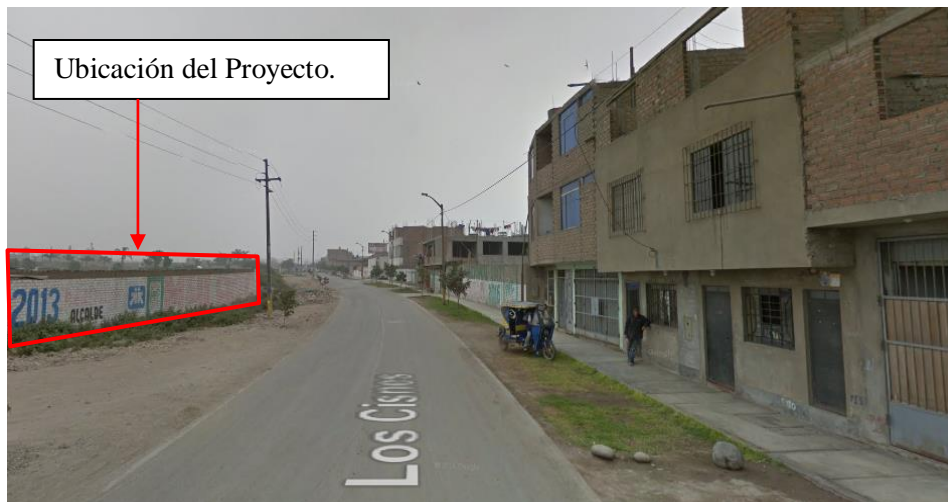
Fotografía 13. Vistas del entorno inmediato al proyecto
